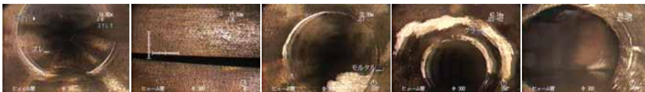
ため池底樋の調査事例
