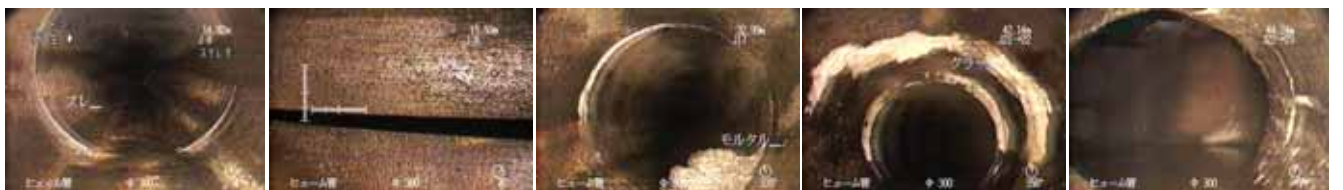
ため池底樋の調査事例
