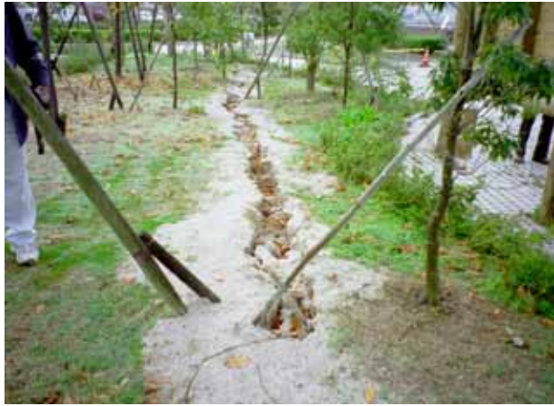
写真 2.6.3 マサ土の噴砂 (米子市錦海町)
