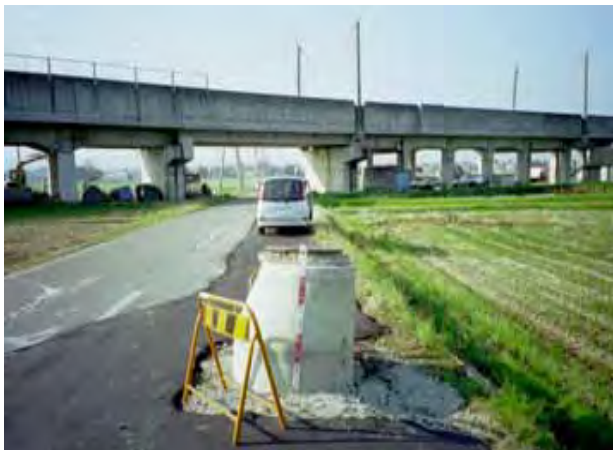
同上。 写真右側約1.5km地点が新幹線脱線停止位置である。 マンホールが1m以上浮き上がっている。 管路は既に修復作業が行われていた。
