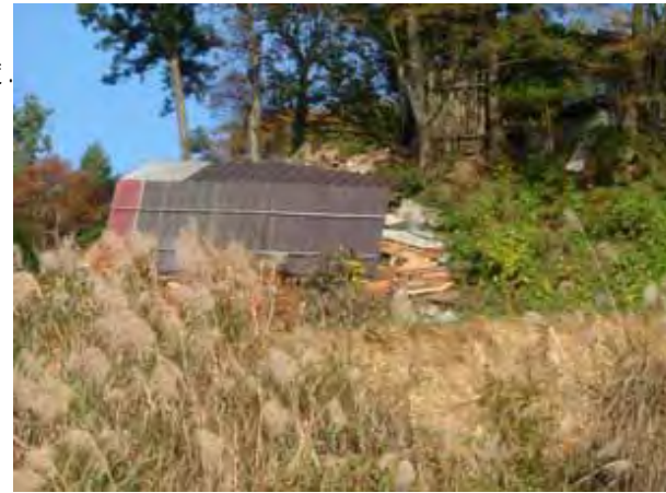
同上。完全に倒壊している。
