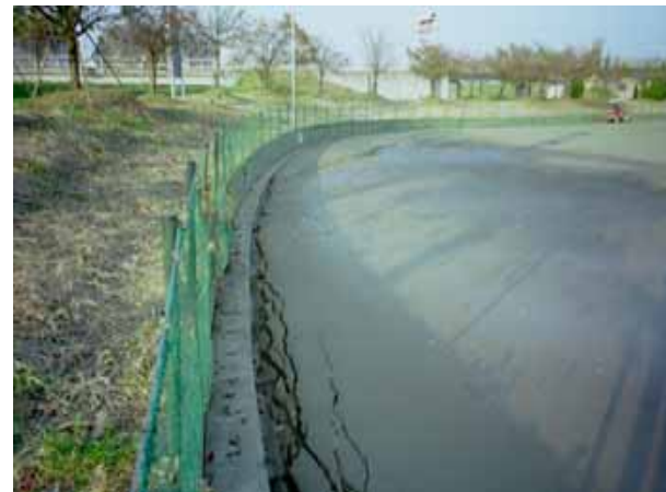
同上。規模の大きな噴砂口の周囲では噴水を伴っている。
