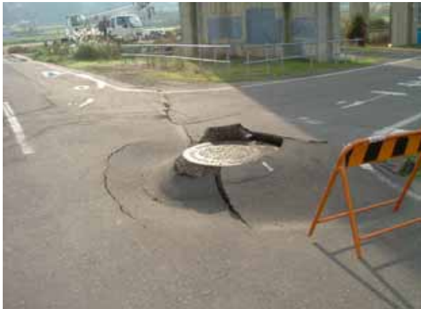
埋め戻し材が液状化し、マンホールの浮き上がりや路面の波打ち等の被害が確認される。
