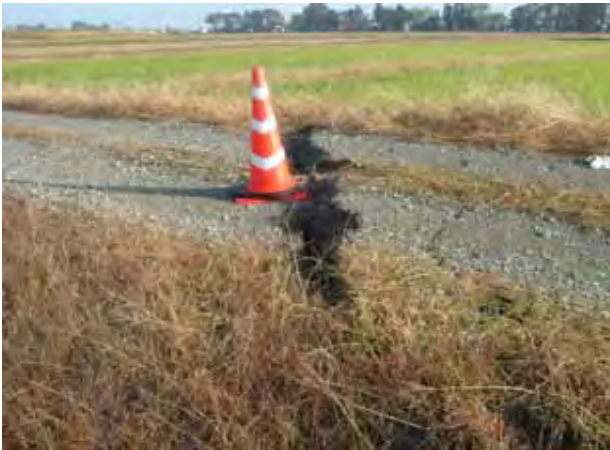
同上。農道の至る所に段差が生じて車輛の通行が困難な状態となっている。
