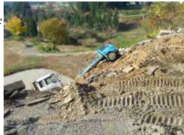
山古志村竹沢地区。 造成盛土の破壊、大型車輛が巻き込まれている。
