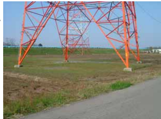
液状化によって水田内にも30cm程度の段差が発生しており、耕作不能な状態となっている。
