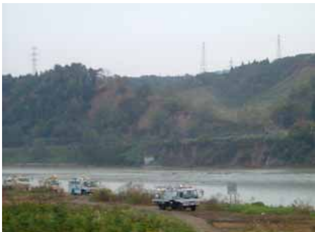
上の写真の下流側状況. 表層崩壊跡が確認される.
