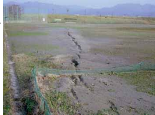
越路町釜ヶ島の水田地帯に見られる噴砂群。広範囲にわたって噴砂・噴水の被害が生じている。
