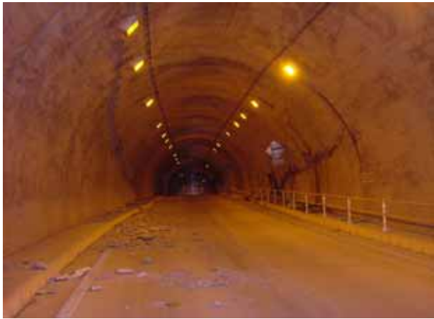
同上。 大きな亀裂は左右両側のほぼ同じ位置に発生している。 写真は峠地区側から木沢地区側を撮影したものである。
