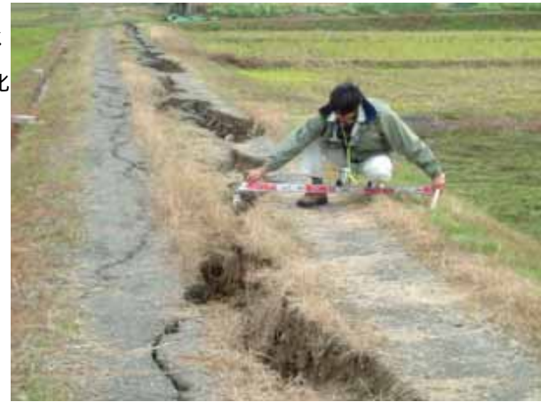
長岡市高島町の農道に見られる段差。最大段差は25cm。
