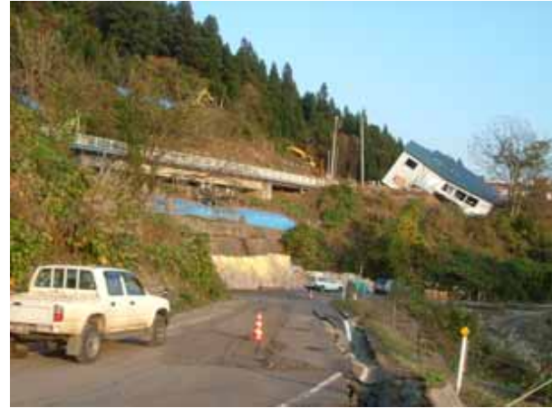
国道17号線川口町天納付近に発生した斜面崩壊。主要道路が通行不能となった。
