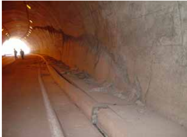
川口町木沢トンネル内の被害。 側壁～アーチ部にかけて大きな亀裂が発生している。 この他、ひび割れが多数発生し、舗装目地が開口している。 写真は木沢地区側から峠地区側を撮影したものである。
