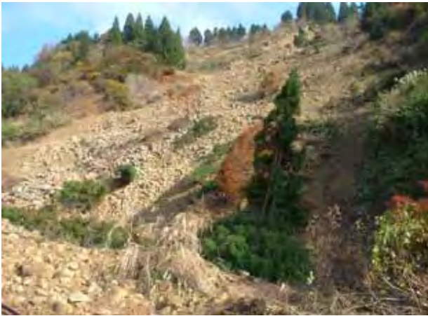
同上。崩壊地の斜面勾配は30～35度。崩壊土は玉石を多く含む。
