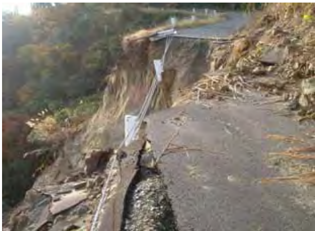
木沢トンネル谷側の旧道に見られる斜面崩壊。 比較的規模の大きな崩壊によって道路は寸断されている。
