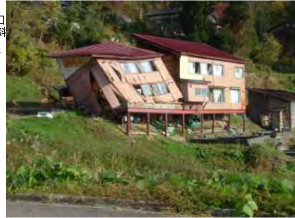
桂谷地区で見られる家屋被害。
