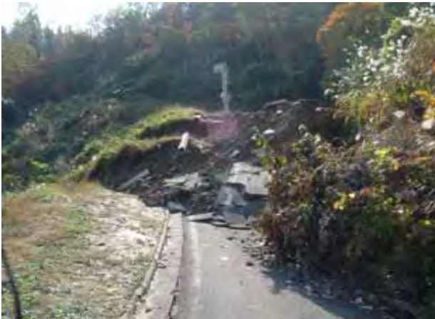
同上。 路面は5m程度の高低差が生じている。
