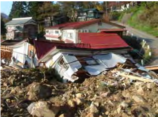
同上。大量の崩壊土砂によって、倒壊した民家。
