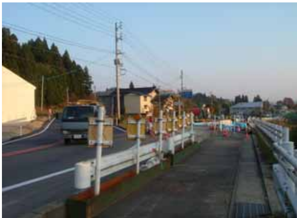
国道17号線は山側を利用して仮迂回路が設けられ、車輛の通行が行われている。
