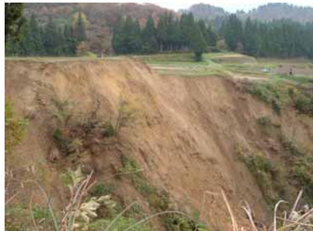
木沢トンネル谷側の旧道に見られる斜面崩壊。 比較的規模の大きな崩壊によって道路は寸断されている。
