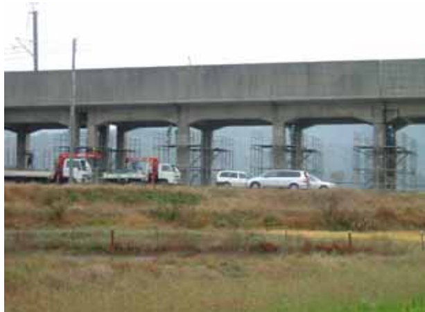
新幹線橋脚の補修作業状況。 比較的橋脚が短くなっている箇所に被害が集中している。
