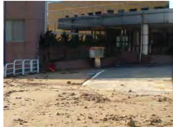
同上。 路面は5m程度の高低差が生じている。
