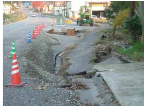
埋め戻し材が液状化し、マンホールの浮き上がりや路面の波打ち等の被害が確認される。
