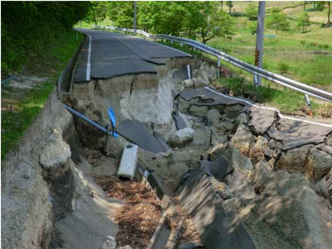
写真-9 崩壊箇所の盛土材料は、白色の石英安山岩質の火砕流堆積物（溶結凝灰岩）起源の砂を多く含む。
