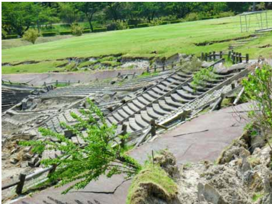
写真-7 副堤の状況
