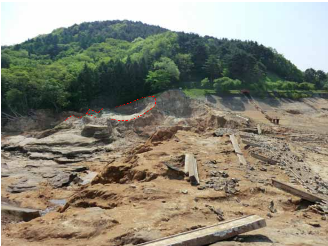
写真-2 決壊した堤体の右岸を望む．下流側斜面に円弧すべりが認められる．この規模のすべりが下流側で連続して発生した可能性がある．
