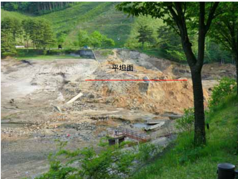
写真-4 左岸か右岸を望む。褐色の堤体残存部分の頂部に平坦面が連続している。
