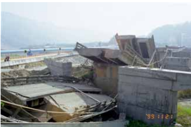
写真 - 3 橋桁の落下(その2)
