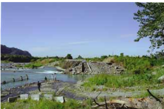
写真 - 4 ダム周辺の状況(その1)
