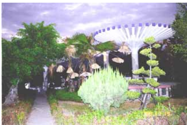
写真 - 7 石岡ダム公園の被害
