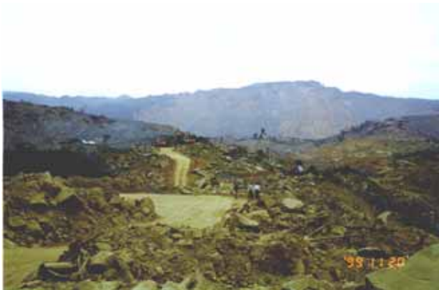
写真 - 1 大規模斜面崩壊(その1)
