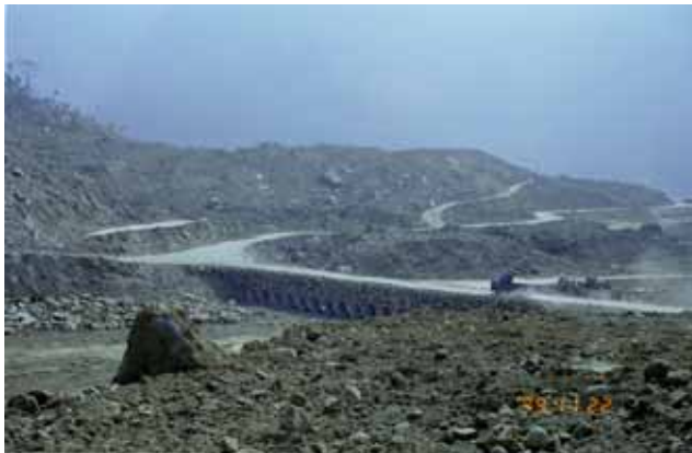
写真 - 10 復旧用の仮設道
