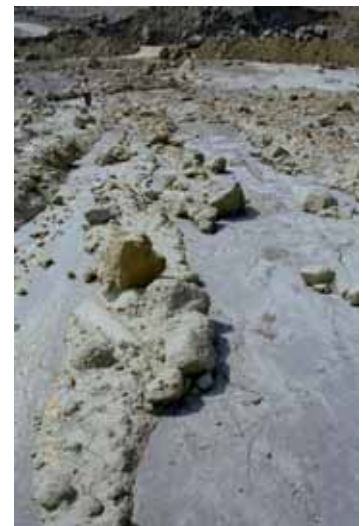
写真 - 9 岩盤のすべり面
