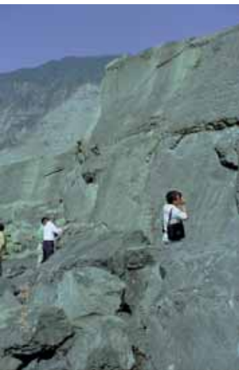
写真 - 7 切り立った破断面(その1)
