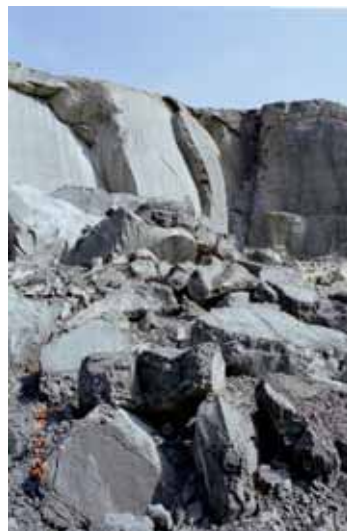
写真 - 8 切り立った破断面(その2)
