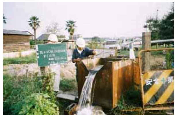
揚水試験状況
