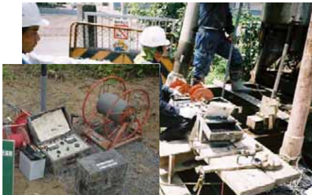
電気検層状況
