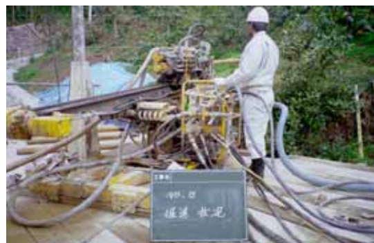
〈ロータリーパーカッション削孔〉
