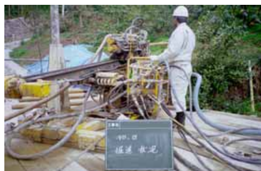
ロータリーパーカッション削孔
