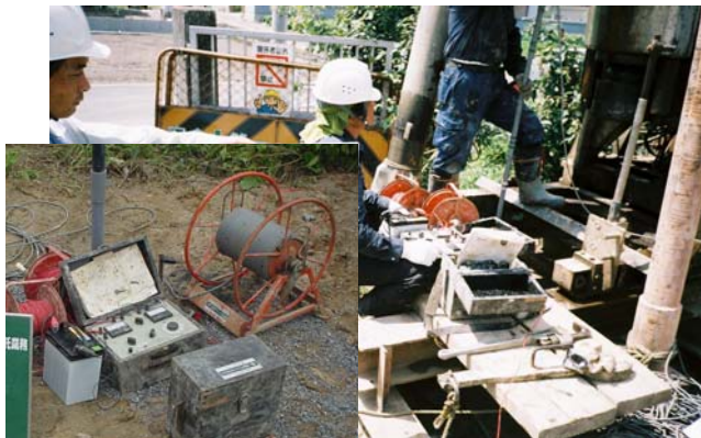
電気検層状況
