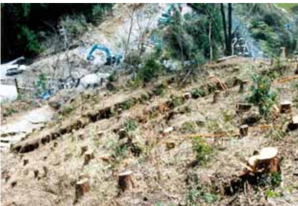
写真-4 斜面に発生した割れ目の状況
