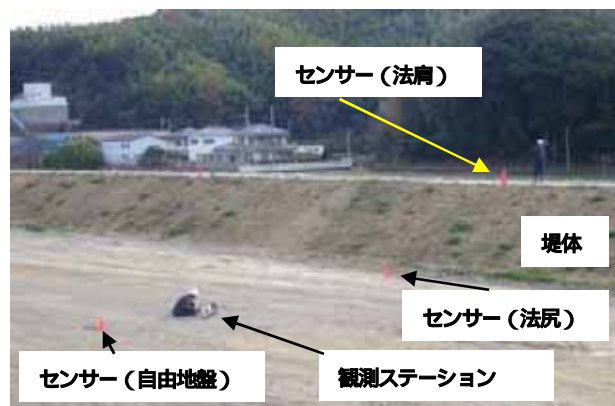
図-27 桑野川河川堤防における常時微動測定の状況（表面波探査測線の中央断面に位置）
