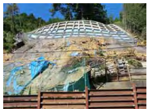
写真-3 対策工の施工状況(2012.10.13)
