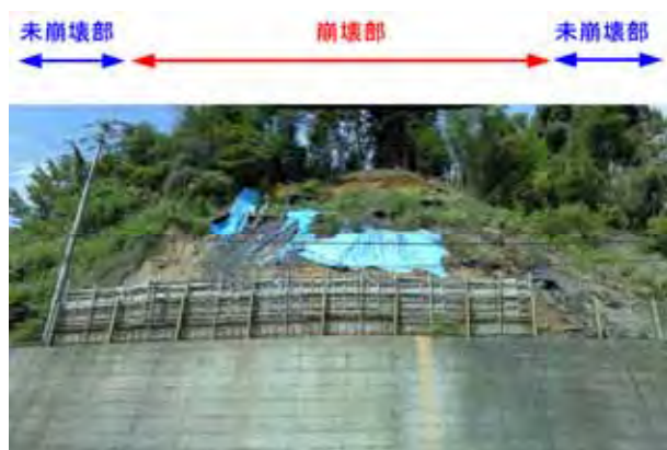
写真-1 表層崩壊の状況
