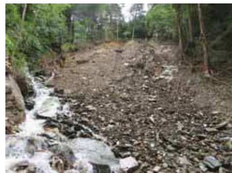
写真-2 斜面末端の侵食・崩壊箇所
