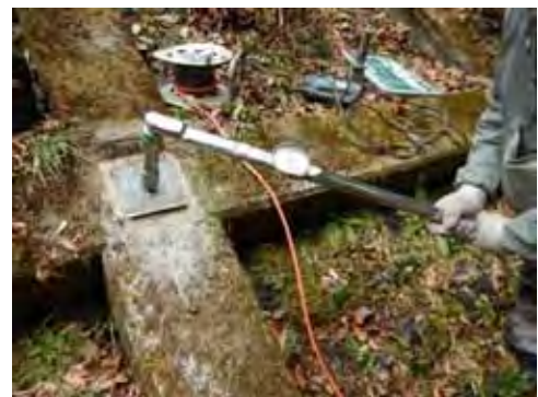
写真-4 トルクレンチ測定状況
