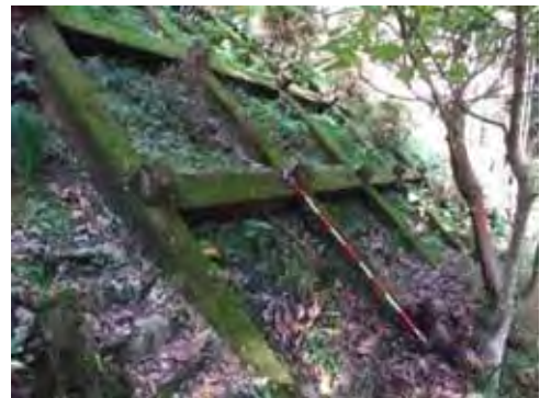
写真-1 のり面状況
