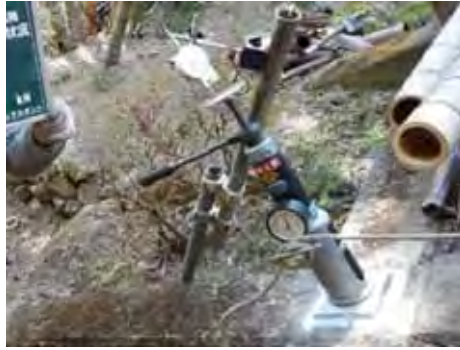
写真-5 ボルトジャッキ試験状
