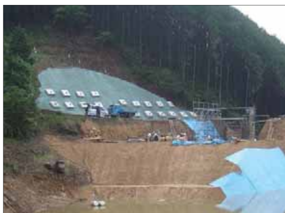
写真5 アンカー工の施工状況
