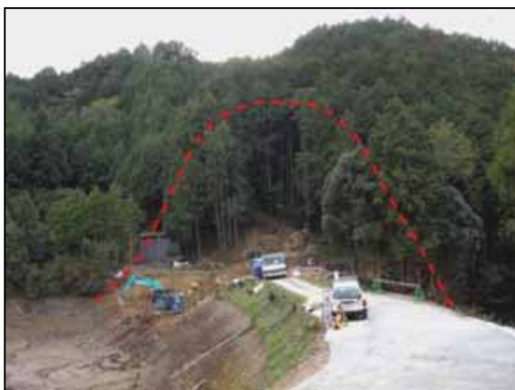
写真1 地すべりブロック全景
